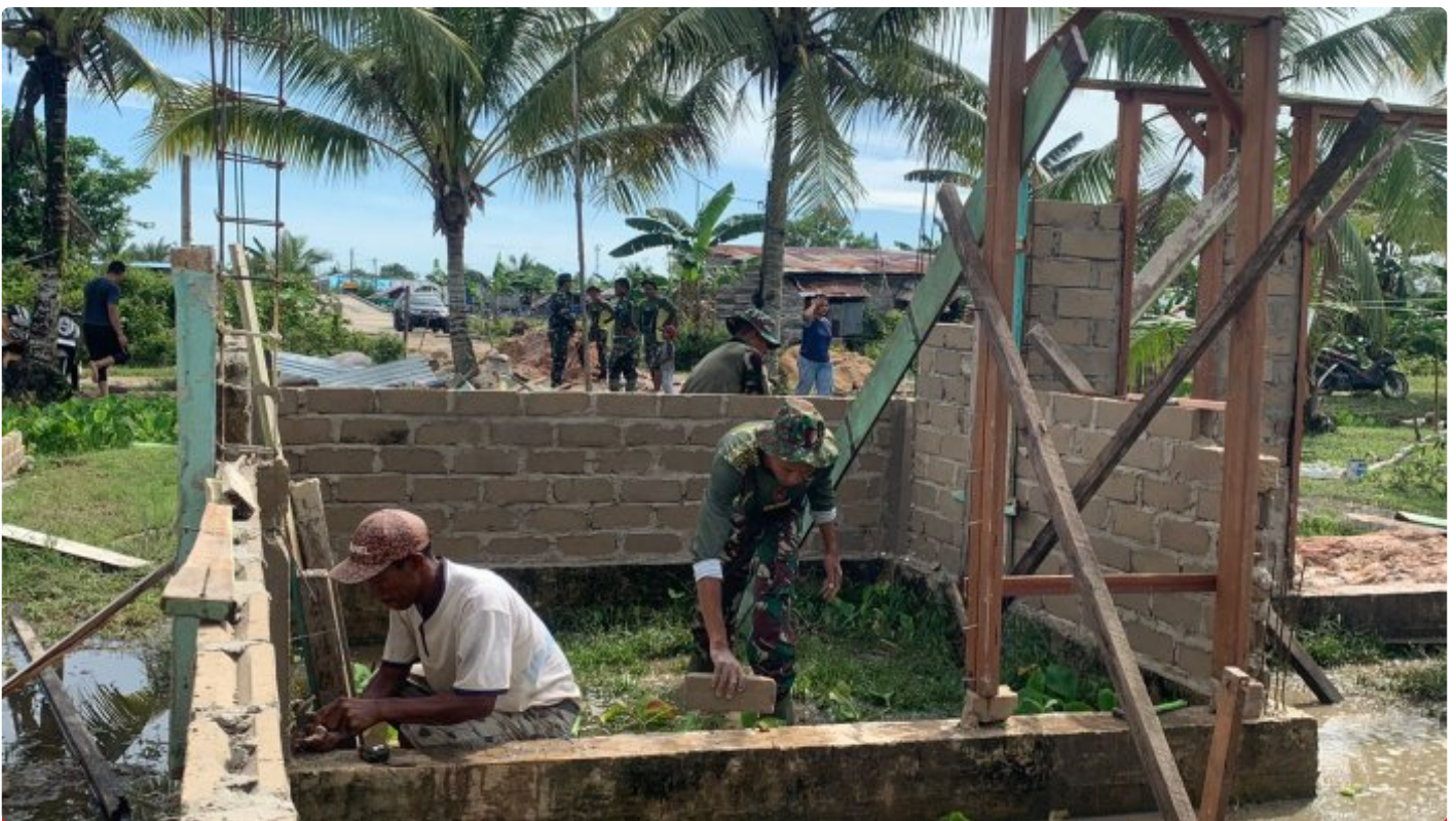
Serma Karno: Tak Ada Kata Lelah, Rehab RTLH Terus Dikebut
